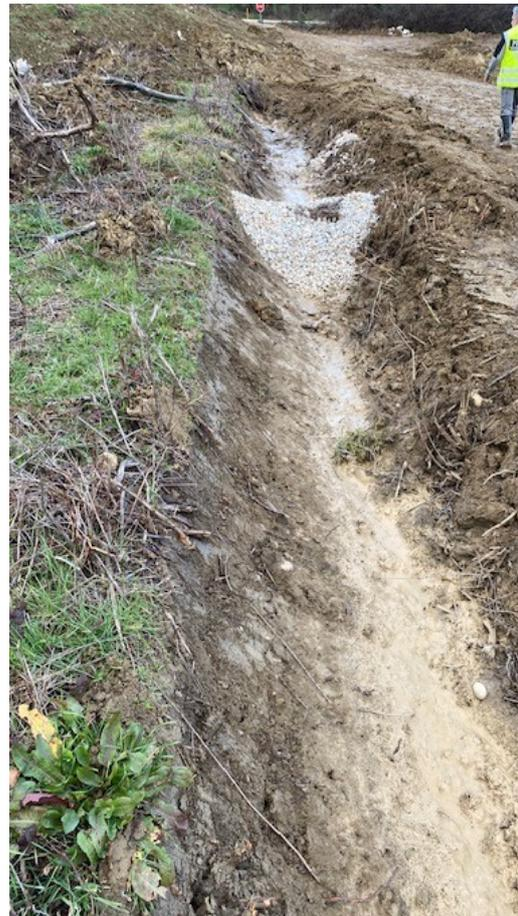
Trace de dépôt et de décantation dans le fossé de filtration situé à la sortie du tuyau de la pompe
