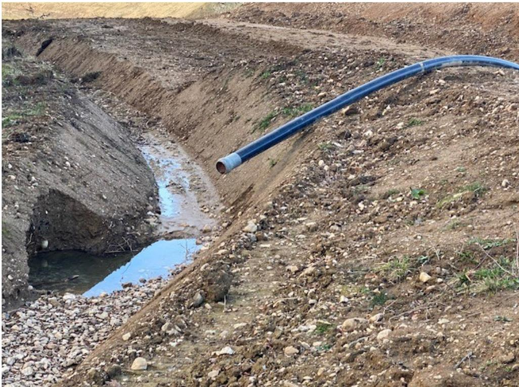
Tuyau de rejet des eaux pompées. On notera une érosion dans le fossé témoignant que de l'eau a été rejetée par ce tuyau.
