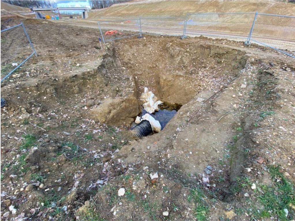
Trou de plus de 2 m de profondeur dans lequel une buse horizontale a été positionnée. Cette buse se rejette dans le plan d'eau situé à une quinzaine de mètres.
