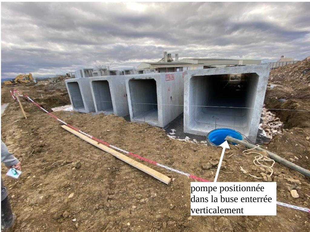
pompe positionnée dans la buse enterrée verticalement
