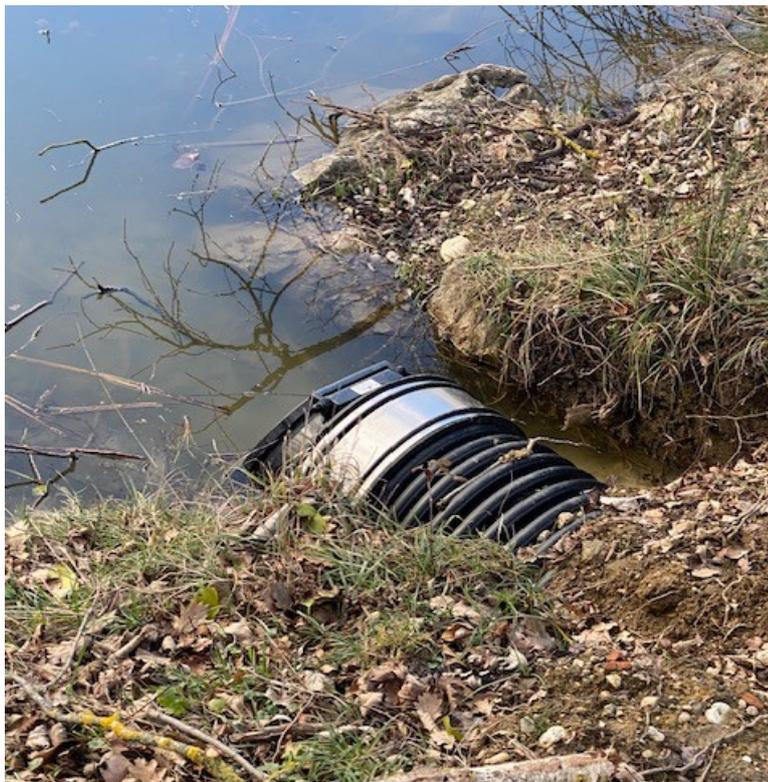
Evacuation des eaux de la nappe dans le plan d'eau. La buse est munie d'un clapet anti-retour pour éviter le retour de l'eau.
