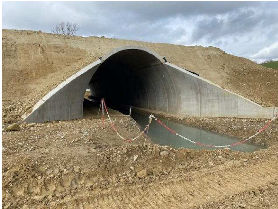
Ouvrage d'art 2930 achevé
