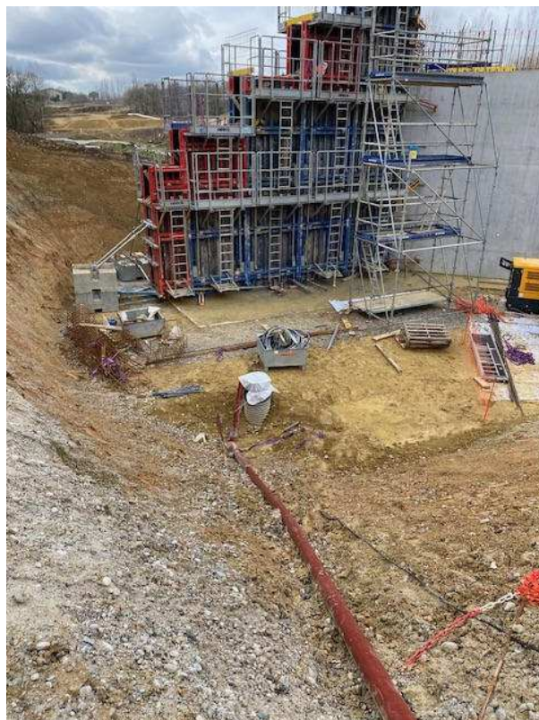
Ouvrage d'art 3862 en cours de construction avec 1 pompe reliée aux compteurs volumétriques
