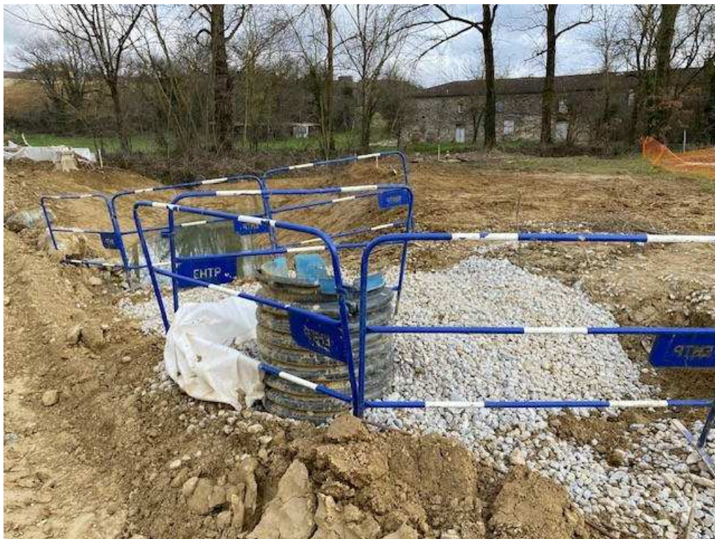
Buse verticale plantée dans le sol nécessaire aux dispositifs de pompage utilisés par ailleurs
