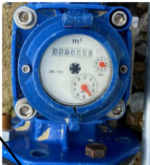
Compteur mécanique affichant 90 058 M3
