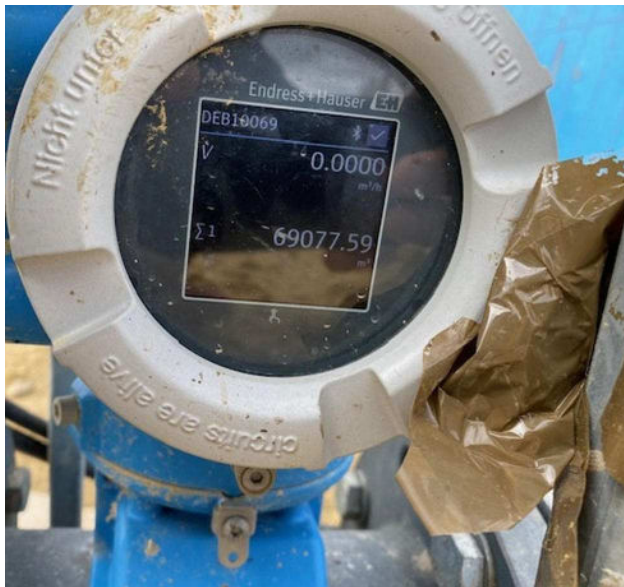
Compteur électronique affichant : 69 077 M3
