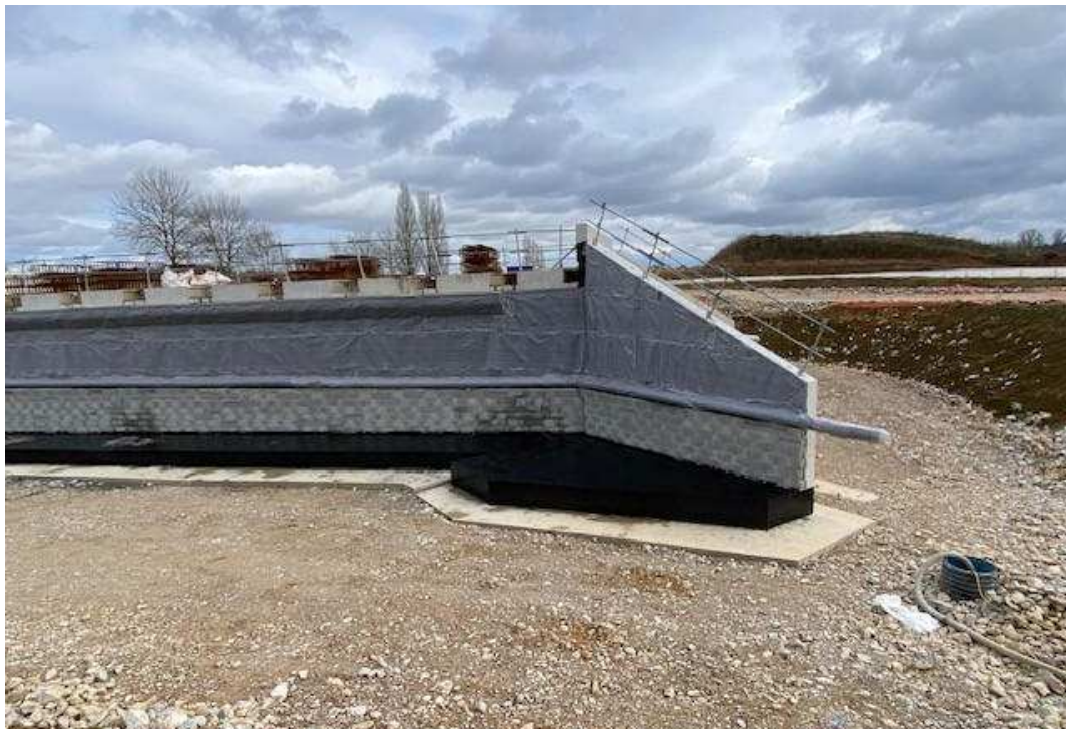
Ouvrage d'art 1917 en cours de construction
